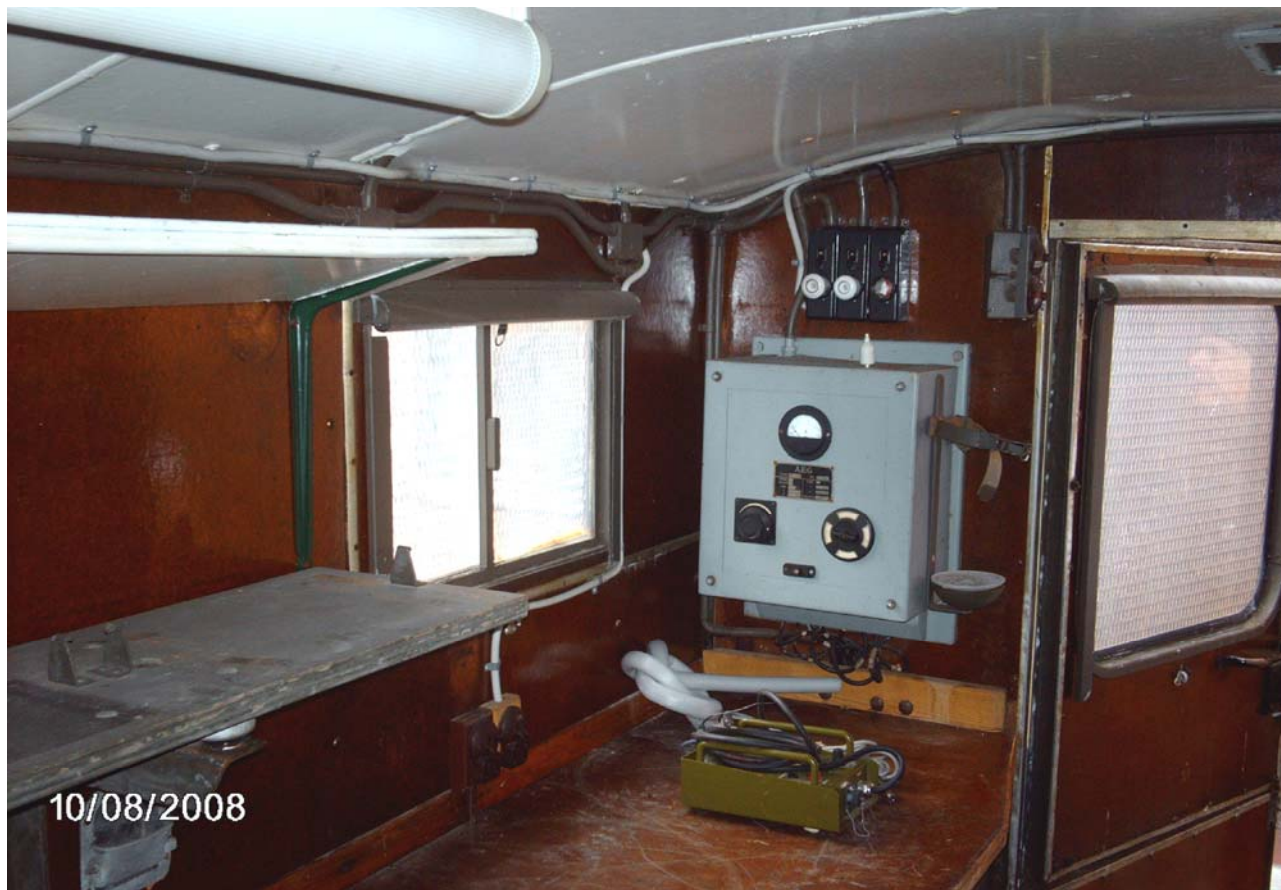
ÆG ladeensretteren til opladning af signalakkumulatorerne.
